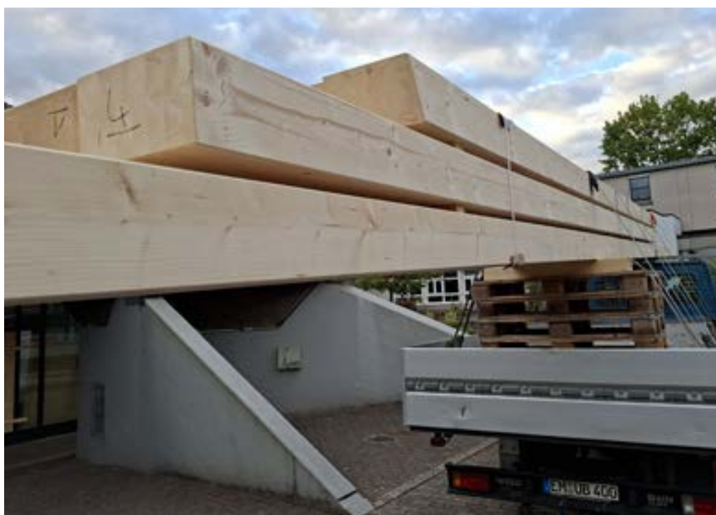
Mit diesen Balken wurde das Dach verstärkt.
